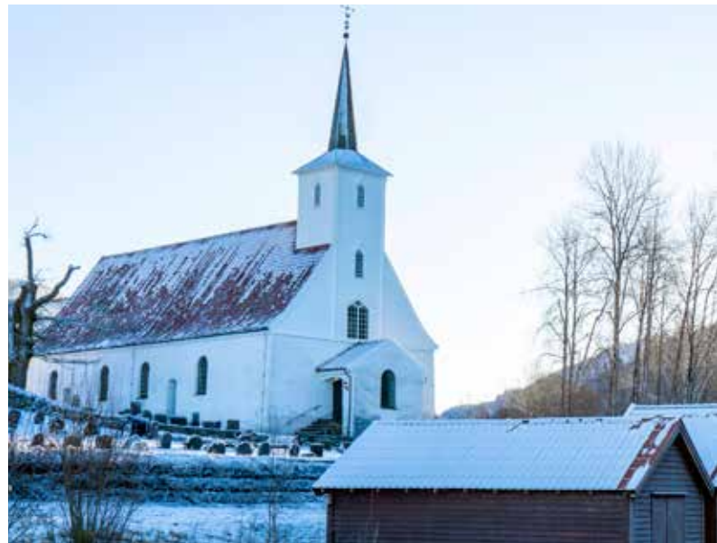
HOSANGER KYRKJE I VINTERDRAKT: Mesteparten av løyvinga gjekk til Hosanger kyrkje, som har fått nytt tak, nykalka vegger, nye omnar under benkane og nytt flomlysanlegg.
